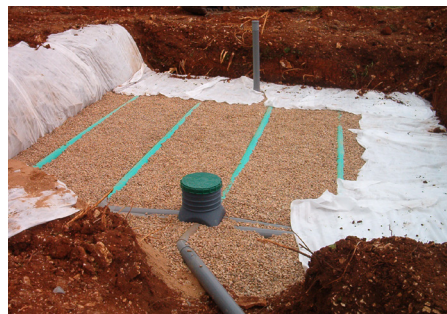
Filtre à sable
