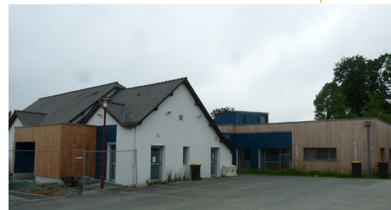
Maison de la Santé à Campbon
